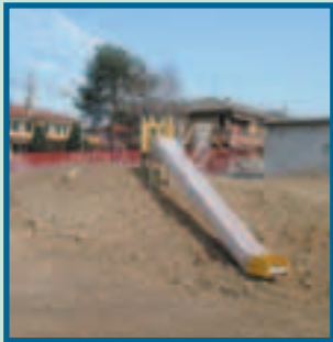
Parco giochi di via Europa - cantiere
