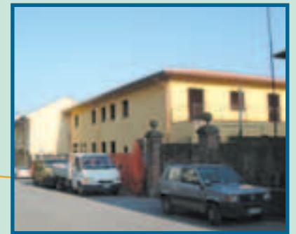
Edificio OASI e aula medica
