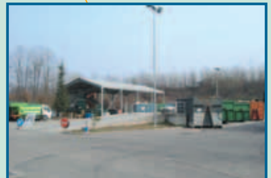
Piattaforma ecologica via Presolana
