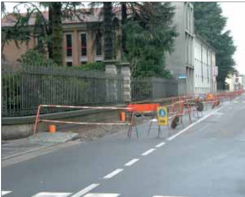
Inizio dei lavori di riqualificazione di via Garibaldi
